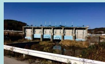
残存した長内川の水門。水門の両側にあった第2防潮堤は津波で破壊されたが、水門はかろうじて崩壊を免れた。
